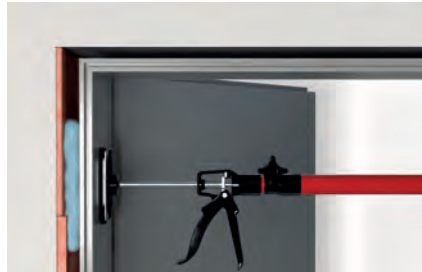
Foaming door frames
